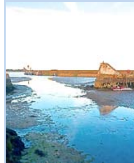
Hier zie je de geul waardoor we eerder die dag zijn gevaren. Toen stond er 4 meter water. De deuren van de haven worden tussen ongeveer 2,5 uur voor en 2,5 uur na hoogwater opengezet. De gesloten deuren houden minimaal 2.30 meter water in de haven.
