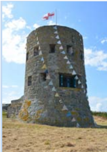
Er staan 14 van dit soort torens op het noord-oostelijke deel van Guernsey, allemaal op 'schootsafstand' van elkaar. Ze zijn ergens in de 18e eeuw gebouwd voor £ 165,- per stuk. Ze zijn opgezet als verdedigingslinie tegen de Fransen.
