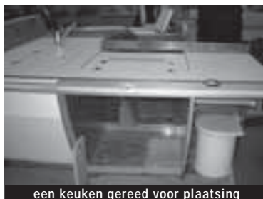
een keuken gereed voor plaatsing
